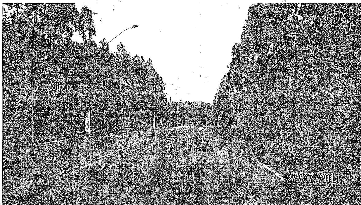
Foto 12: Avenida Fumiaki Yamamoto (Viário Metropolitano Secundário – proposta SIVIM/2006): sentido centro de Caieiras, Franco Rocha e Mairiporã, há necessidade de melhoria no tratamento a segurança do tráfego.
